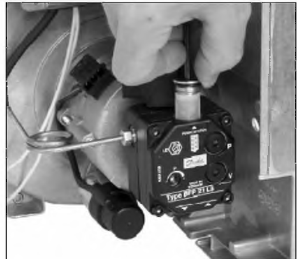
Рисунок 29 – Демонтаж топливного фильтра
